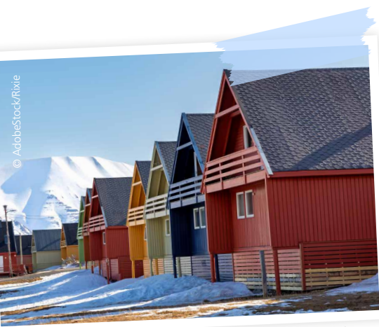
M1: Häuser auf Stelzen in Spitzbergen.
